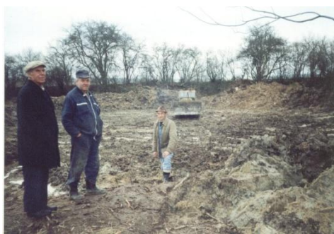
Úprava a obnova vodních zdrojů
